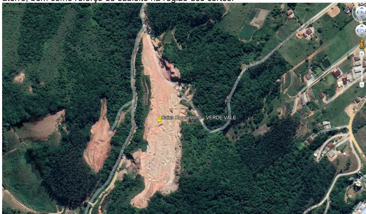
Figura 9.4: Caixa de Empréstimo Verde Vale
