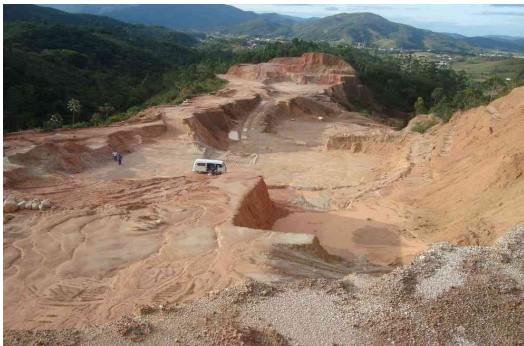
Figura 6.7 - Visão geral da caixa de empréstimo Verde Vale
